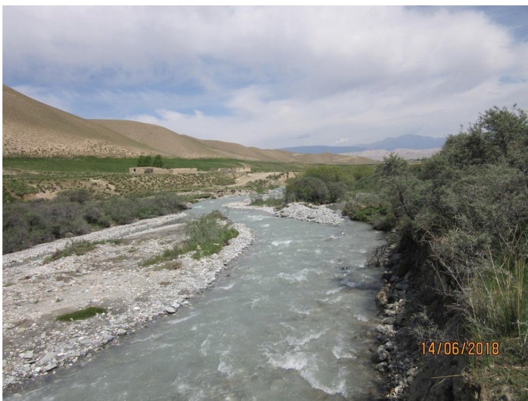
Фото2. Головной водозабор на канале «Кытат-Арык», июнь 2018г.
