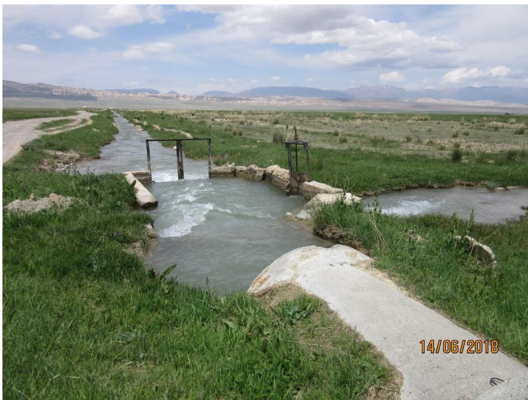
Фото №3. Шлюз-регулятор на канале «Баш-Келтебек», июнь 2018г.
