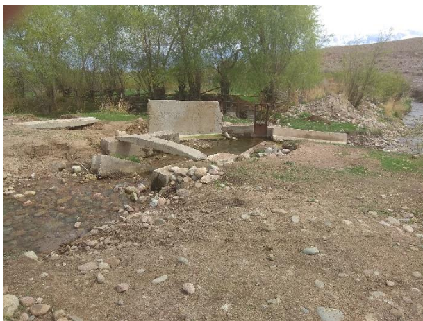
Фото №1. Водовыпуск на канале «Тосорский», сентябрь 2019г.
