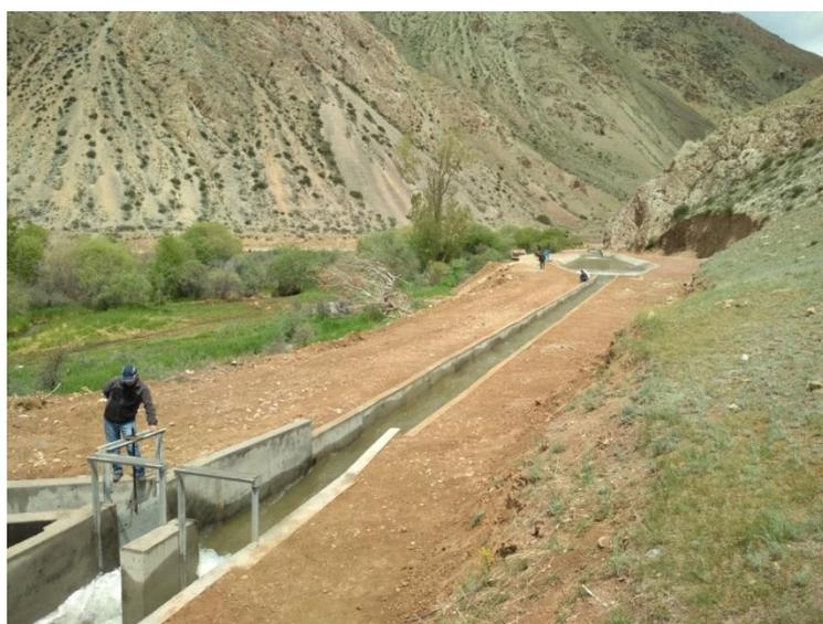
*АВП «Токтомуш». Отстойник канала Жаны-Арык до и после реабилитации*
