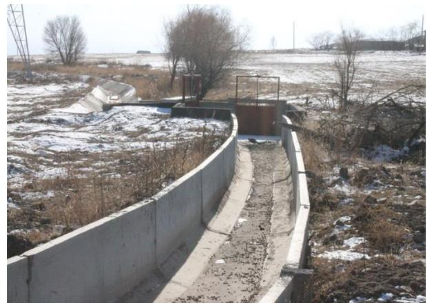
*АВП «Токтомуш». Шлюз-регулятор на канале Чолок до и после реабилитации*
