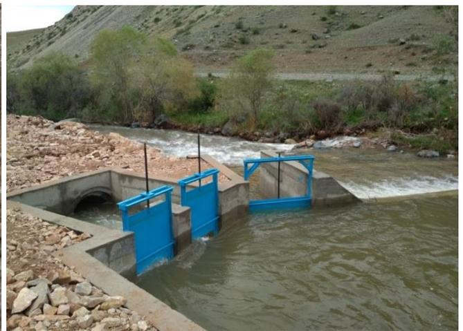
*Головной шлюз-регулятор канала Жаны-Арык до и после реабилитации*
